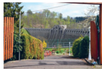
Die Staumauer der Talsperre Klingenberg
