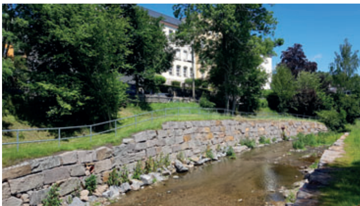
An der Schulstraße wurde die Gewässersohle der Zwönitz auf einer Länge von ca. 130 Metern abgesenkt, das Wehr zurückgebaut und neue Stützmauern errichtet.
