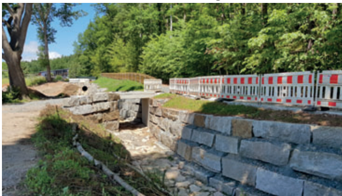
Im Bereich Waldstadion und Bolzplatz am Vereinshaus wurde die Bachverrohrung erneuert und ein Teil des Pfarrgrundwassers offen gelegt.
