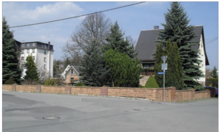
Um 1920 macht das Gebäude bereits einen reparaturbedürftigen Eindruck.
