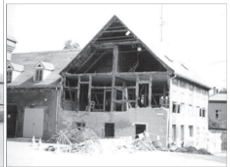
... 1986 während des Abrisses
