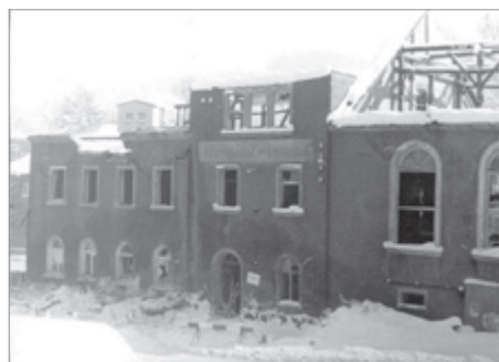
1987 wurde mit dem Abriss des Gebäudes begonnen.
