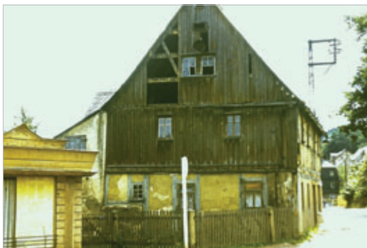
Kein schöner Anblick: die mit Brettern verschaltete Giebelwand beginnt sich aufzulösen.
