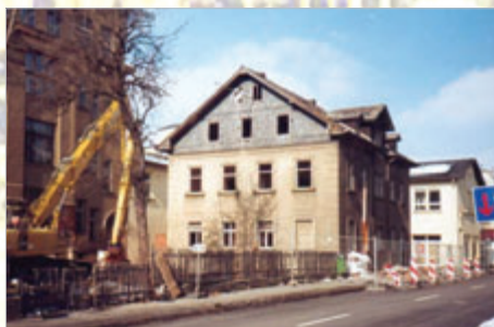
Abriss des Gebäudes im März 2004
