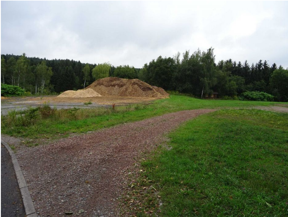
Foto 1: Blick von der Südspitze des Geltungsbereichs (Berghausweg) in Richtung Nordwesten: Lagerfläche mit Holzschnitzelhaufen, links davon einer 2 Staudenknöterichbestände, rechts davon verbretterter Schuppen und daneben der zweite Staudenknöterichbestand, 16.08.2019.
