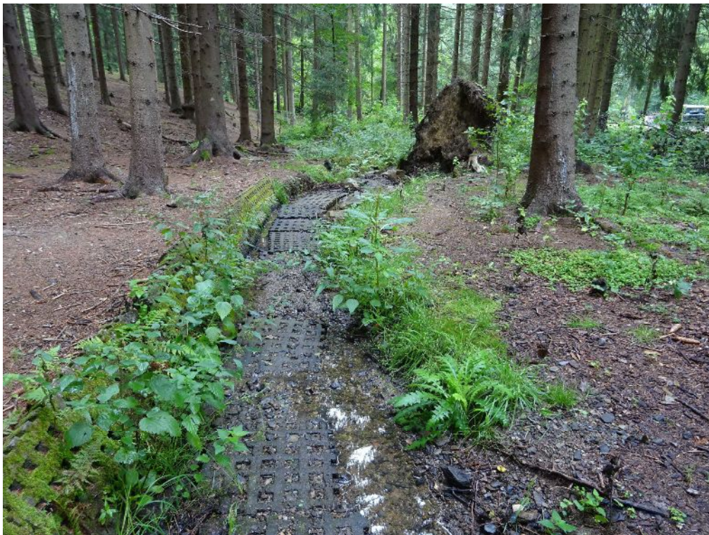
Foto 18: Mit Betonlochplatten befestigter Gewässerlauf im Waldbestand nördlich der Gärten unterhalb der Plateaufläche, 16.08.2019.
