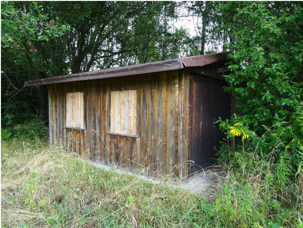
Foto 12: Verbretterter Schuppen an der Nordgrenze des Geltungsbereichs,16.08.2019.
