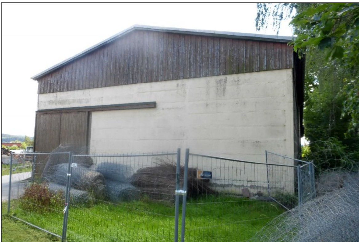
Foto 2: Holzverkleidung an der Bergehalle.
