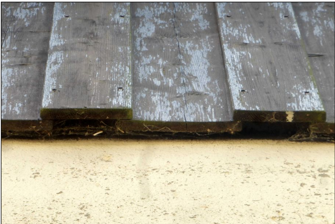
Foto 4: Im Bereich der Holzverkleidung ergeben sich Spaltenquartiere, die von Fledermäusen genutzt werden können.
